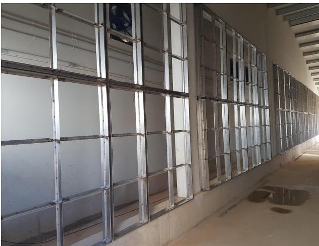
Estos sistemas herméticos están diseñados para minimizar el riesgo de fugas hacia el lado de aire limpio, con un sistema exclusivo sin clips adicionales que permite una rápida instalación y retirada de los filtros. Todos los componentes de las estructuras están fabricados en acero inoxidable AISI 304 para una mayor resistencia a la corrosión y una larga duración. El sistema se completa con el Sensor360 para monitorizar los niveles de calidad del aire y el rendimiento de filtración.
